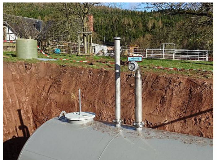
Löschwasser-Sauganschluss gem. DIN 14230
