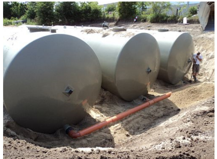
Löschwasser-Sauganschluss gem. DIN 14230
