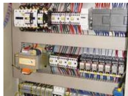
Schaltschrank / SPS-Steuerung
