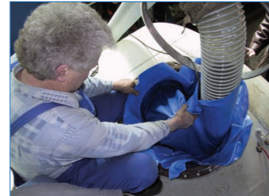
Einbau von Kunststoffinnenhüllen / Leckschutzauskleidungen inkl. Leckanzeiger
