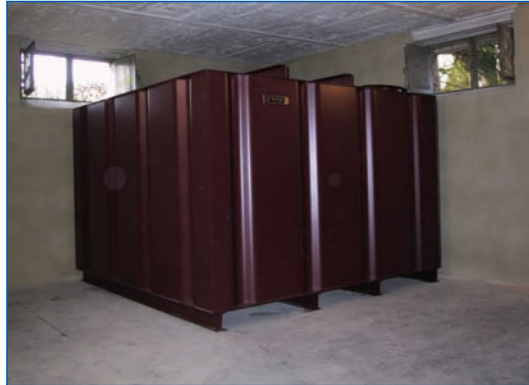
Kellergeschweißte Lagerbehälter nach DIN 6625 mit und ohne Kunststoffinnenhülle 1.000 - 100.000 Liter Inhalt
