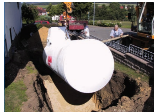
Lieferung, Einlagerung und Montage von Erdtanks incl. Erdarbeiten 1.000 - 100.000 Liter Inhalt
